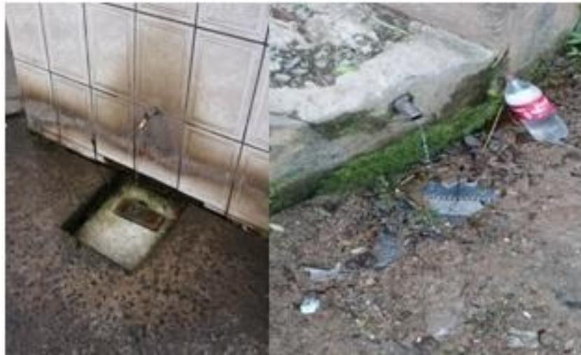
Figura 5.2 - Pontos de captação de água da nascente do Bairro Vila Maria.
