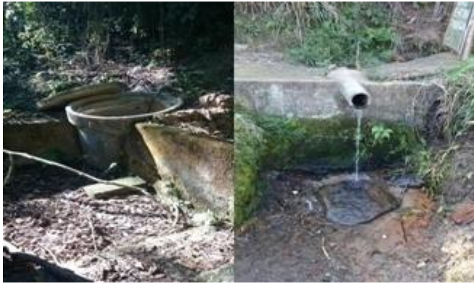
Figura 5.1 - Estado de degradação das nascentes. À direita bairro Piteira e à esquerda Rialto (mina do beco)
