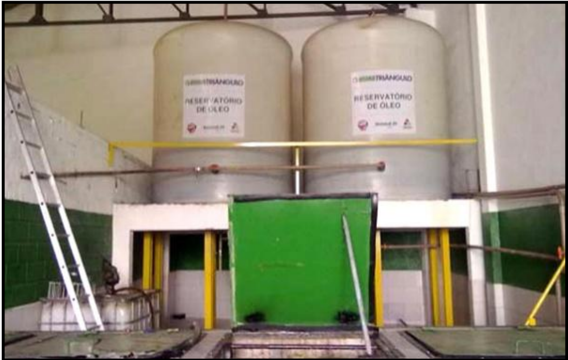
Figura 12 – Reservatórios de óleo vegetal residual na “Usina Verde” do Instituto Triângulo. Fonte: INSTITUTO TRIANGULO, 2016
